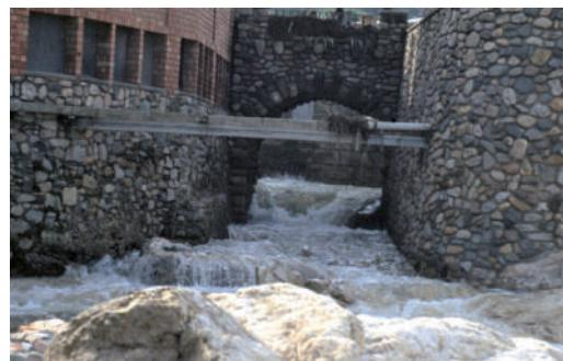
Figura 9. Crescuda a la Font Major. Sobre la viga es veuen les restes vegetals deixades en el nivell on va arribar l'aigua en aquesta crescida (octubre de 1994).
