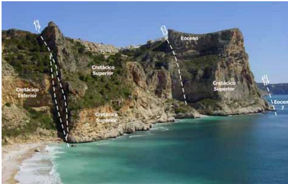
Figura 9. Panorámica del extremo norte de la cala del Moraig donde se observa cómo la falla del Moraig, hacia el norte, se ramifica en varias fracturas (ver figura 5A). En la fotografía se han señalado tres de las más importantes.
