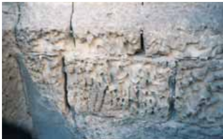
figura 41 - Ejemplo de sillares y sus correspondientes llagueados antes de su última restauración. Los sillares bajos de las rocas más porosas (las calizas oolíticas y las calcarenitas), han sufrido importantes procesos erosivos de arenización y alveolización . Estos procesos están relacionados con la humedad del suelo, que asciende por capilaridad a través de los sillares arrastrando iones salinos. A partir de dichas soluciones y su interacción con la roca se forman minerales cuya presión de cristalización "rompe" la roca.
