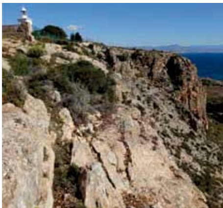
figura 23 - Viviendas próximas a los escarpes rocosos en Santa Pola del Este. Obsérvense los bloques desprendidos a los largo de toda la ladera. La línea amarilla define la posible trayectoria de un bloque desprendido.
