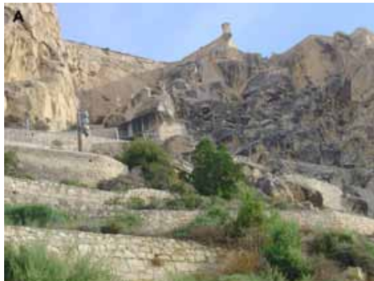
Figura 13. A) Acumulación caótica de bloques en la zona afectada por la explosión, observándose algunos muros de protección.
