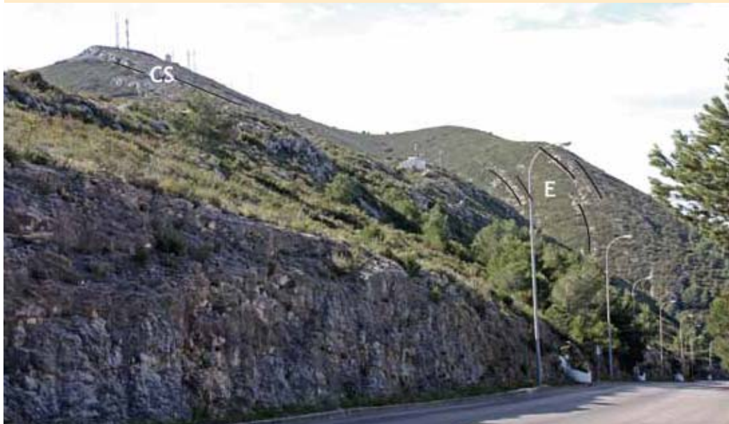
Figura 3. Panorámica hacia el SSW (hacia lo alto de la Llorença) desde el mirador turístico situado en la carretera entre Benitatxell y la urbanización Cumbres del Sol. Se observan las capas plegadas del Cretácico Superior (CS) y del Eoceno (E).
